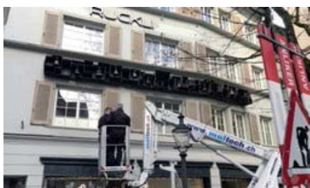
Restaurationsarbeiten des Glockenspiels am Haus Ruckli in Luzern. / Le carillon sonne de nouveau les heures dans la maison Ruckli de Lucerne.
