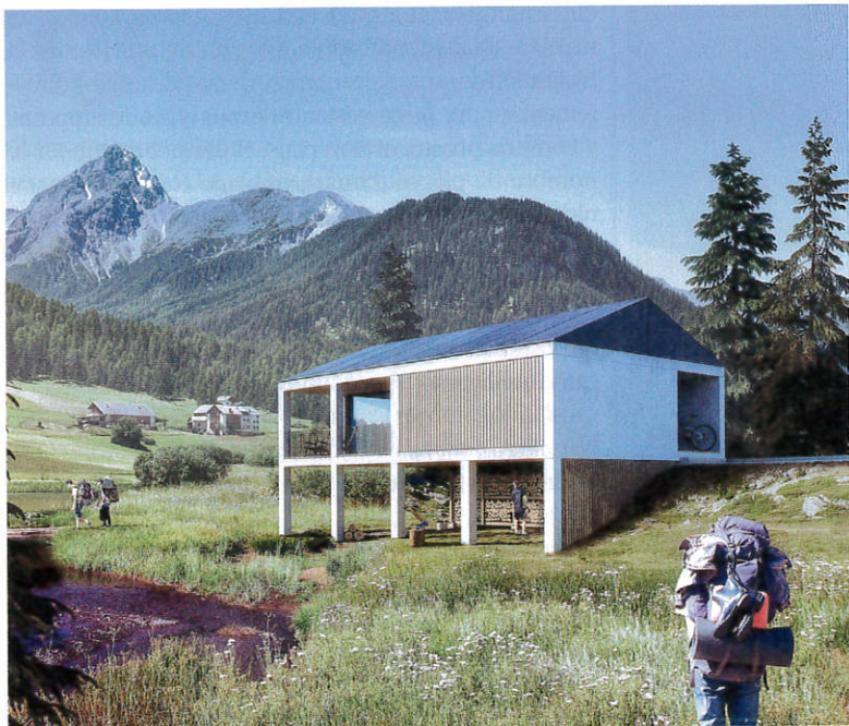
Les constructions modulaires baptisées Ustinov Construction System valorisent le PET recyclé sur le principe de l'assemblage des Lego.
